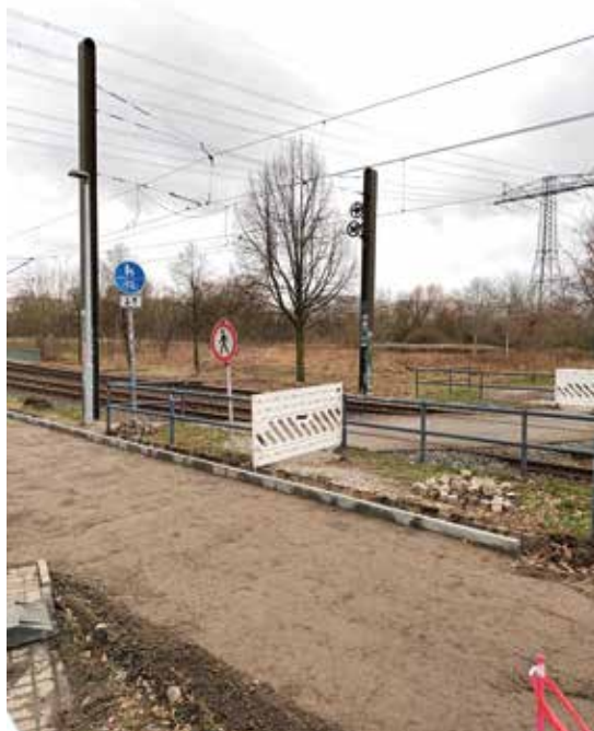
Bei Dunkelheit ist der Straßenbahnübergang schlecht einsehbar. Verbesserung könnte zusätzliche Beleuchtung von der Wittenberger Straße aus, eine Ausschilderung und die Langsamfahrt der Tram bringen.
